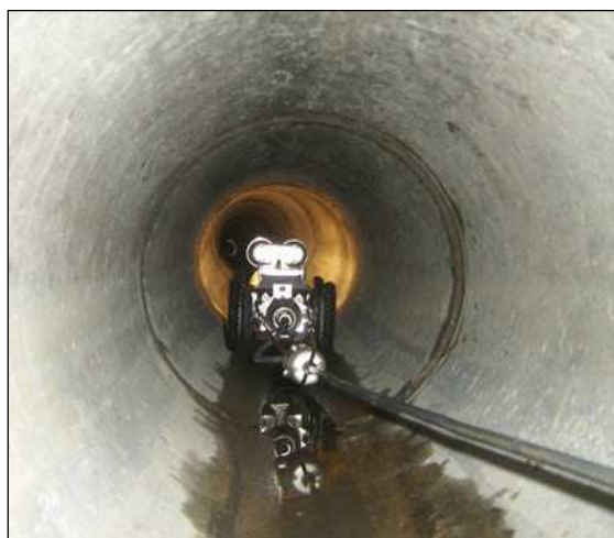
Fig. 2-f : Inspection caméra
